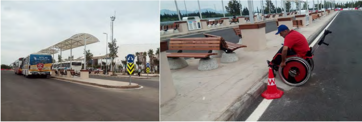
Fotoğraf 14. Antalya Expo otobüs durağı: Durağa standartlara uygun erişilebilir rampa oluşturulmamış, mobilyalar yeterli manevra alanları olmayacak şekilde yerleştirilmiş.
