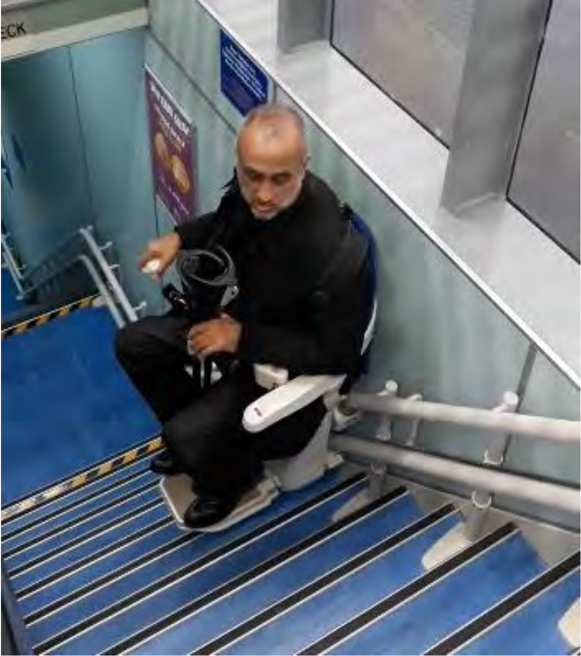
Fotoğraf 35. İDO İstanbul Yalova seferi, gemi içerisinde hareket kabiliyeti kısıtlı bireylerin merdiveni çıkabilmeleri için oluşturulan koltuklu asansör sistemi.
