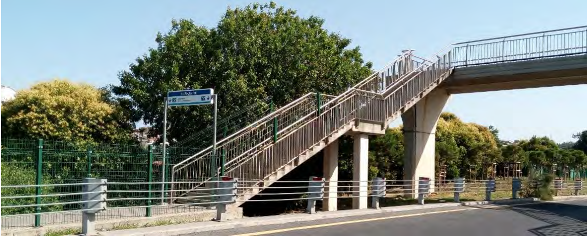
Fotoğraf 16. İstanbul Burhaniye Metrobüs Durağı üst geçit bağlantısı, rampa veya asansör uygulaması yok.
