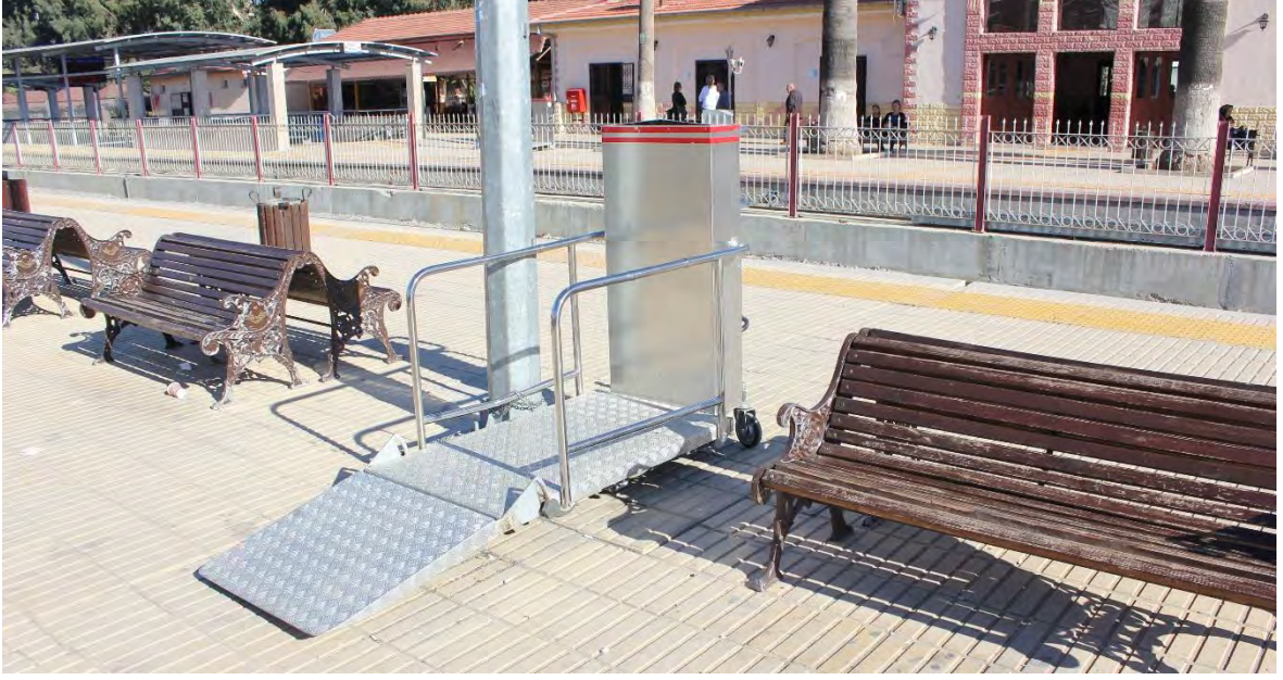
Fotoğraf 25. TCDD Tarsus İstasyonu, tekerlekli sandalyenin vagona binmesine yardımcı manuel asansör sistemi.
